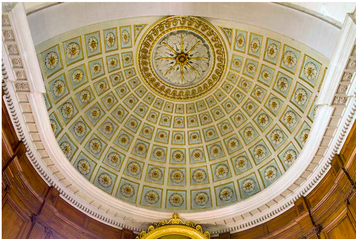
Voûte à caissons, chœur de l'église.
