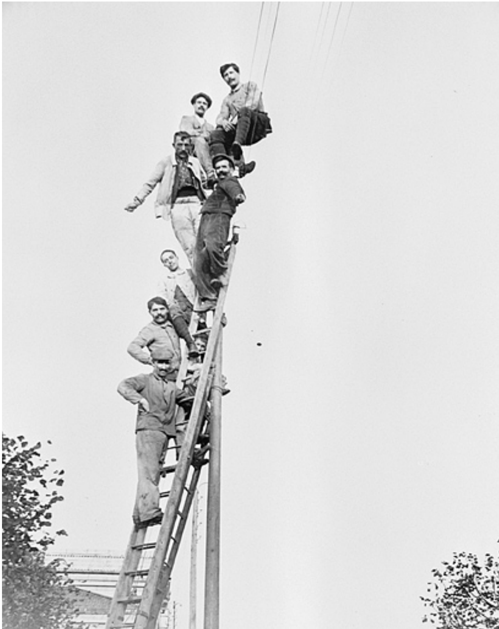
[Poseurs de ligne sur un poteau électrique], 1913 ?
