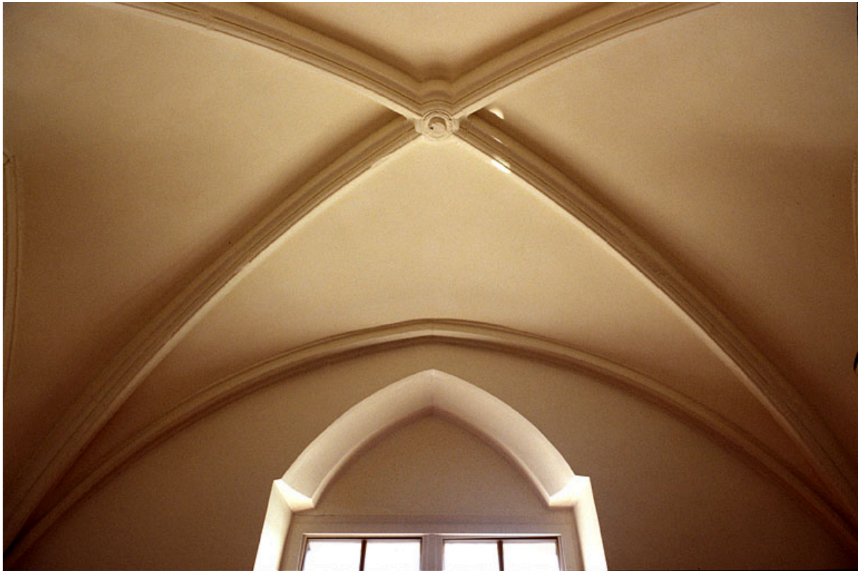
Maison du Pardessus dite aussi du Grand puits. Voûte de la chapelle (2005).
