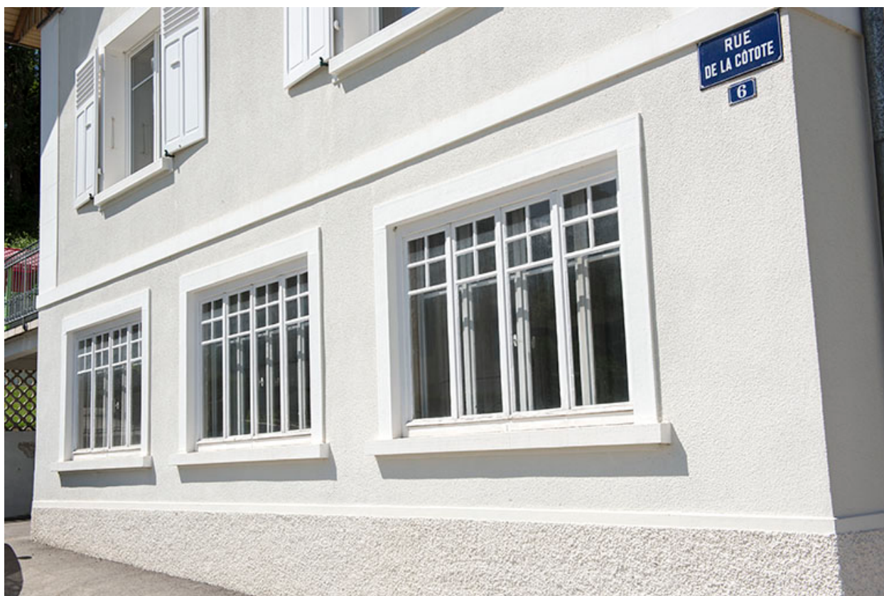
Façade latérale gauche : baies d'atelier.
