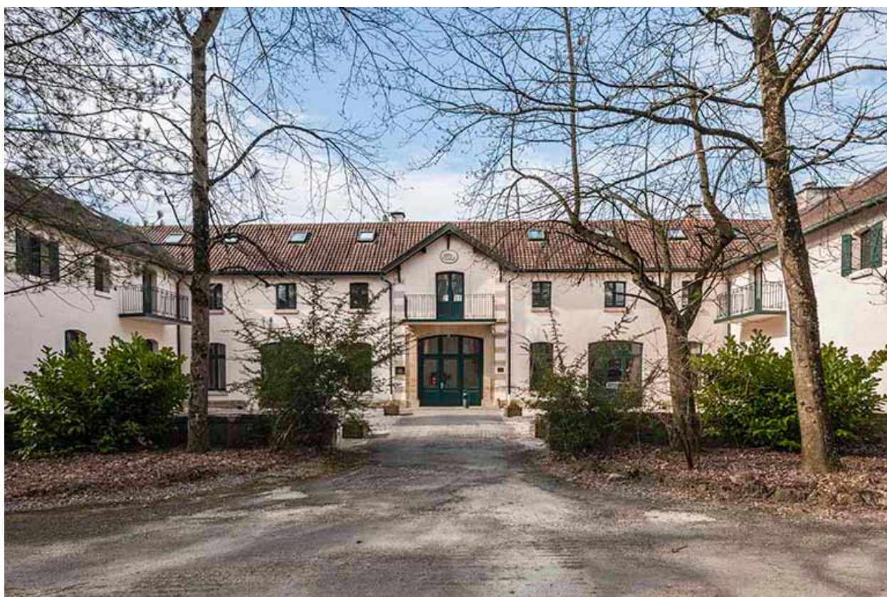
Bâtiment des communs. Vue axiale.
