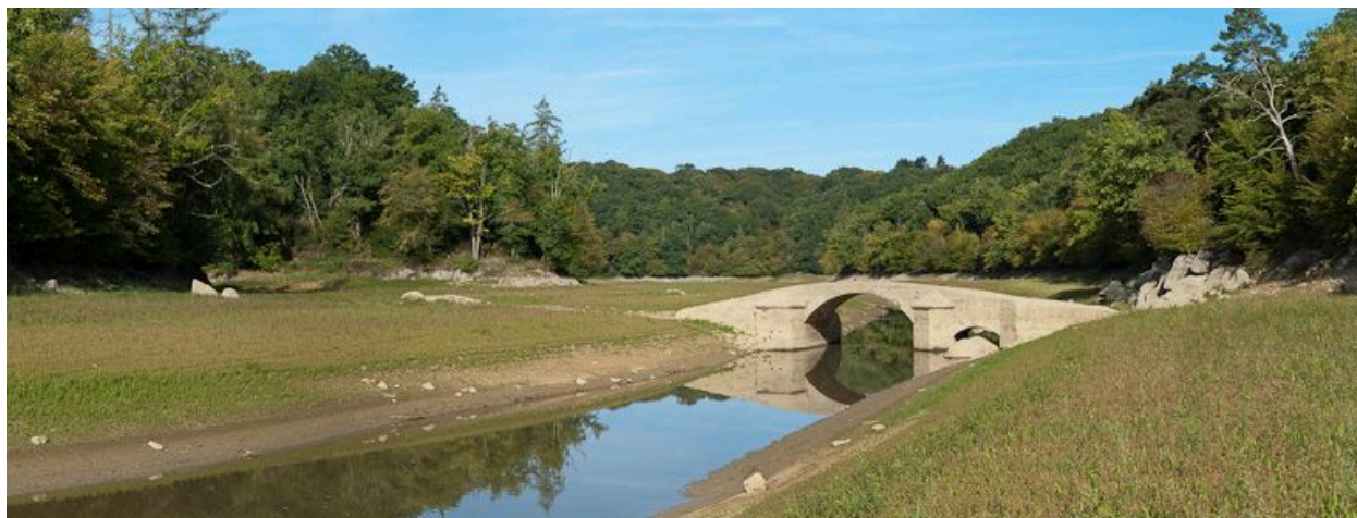
Vue du pont.
