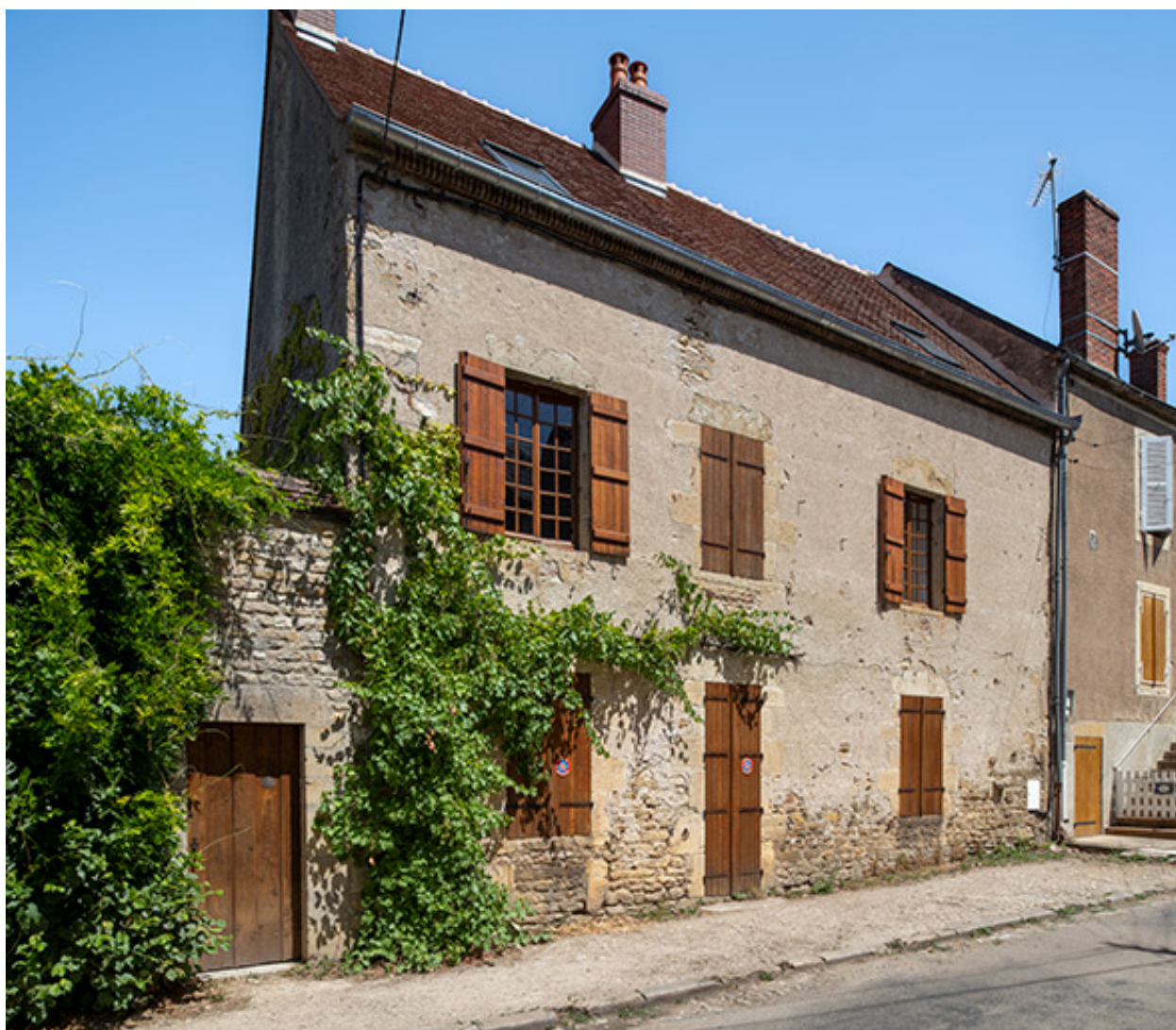
La maison sur rue.
