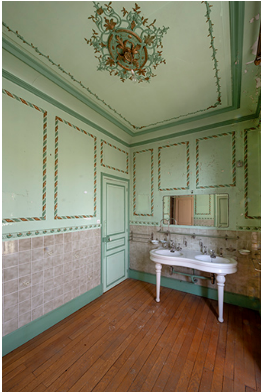
Premier étage, salle d'eau.
