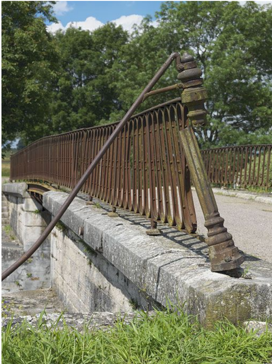
Pont sur écluse : détail du garde-corps.
