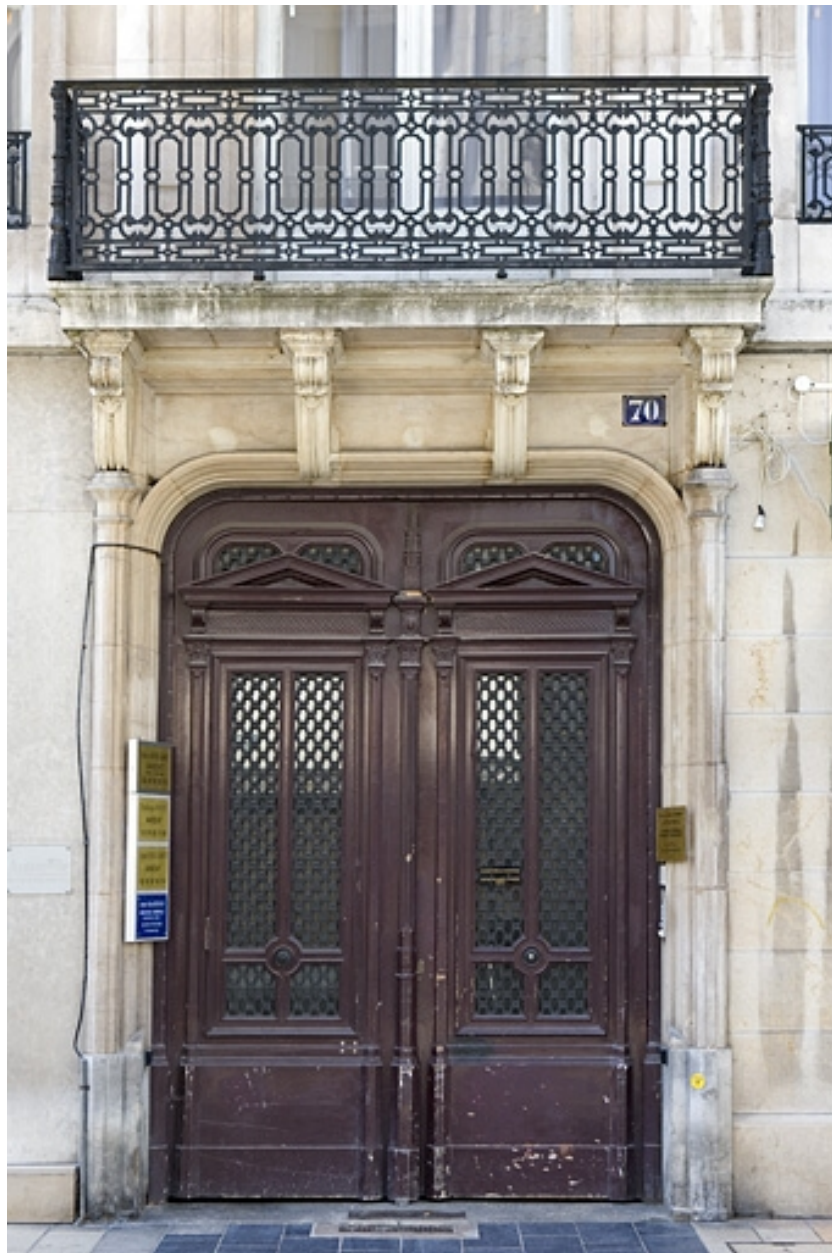
Détail du portail d'entrée sur rue.
