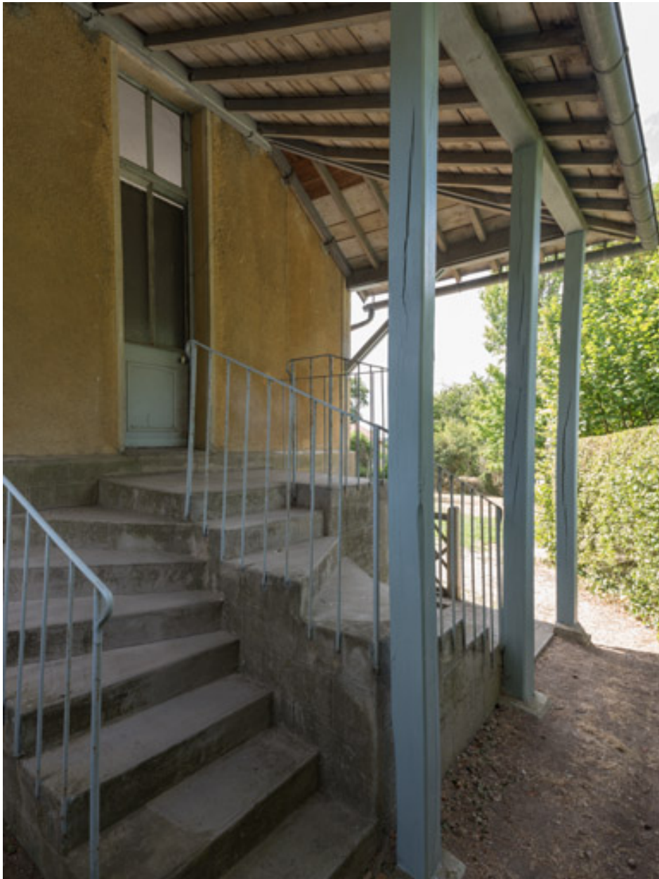
Entrée latérale, côté nord.
