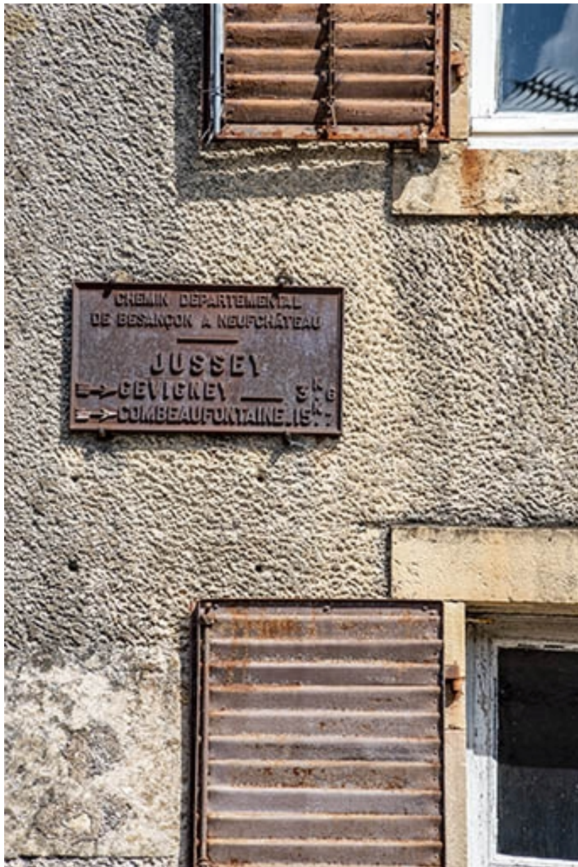
Détail de la façade avec plaque directionnelle.
