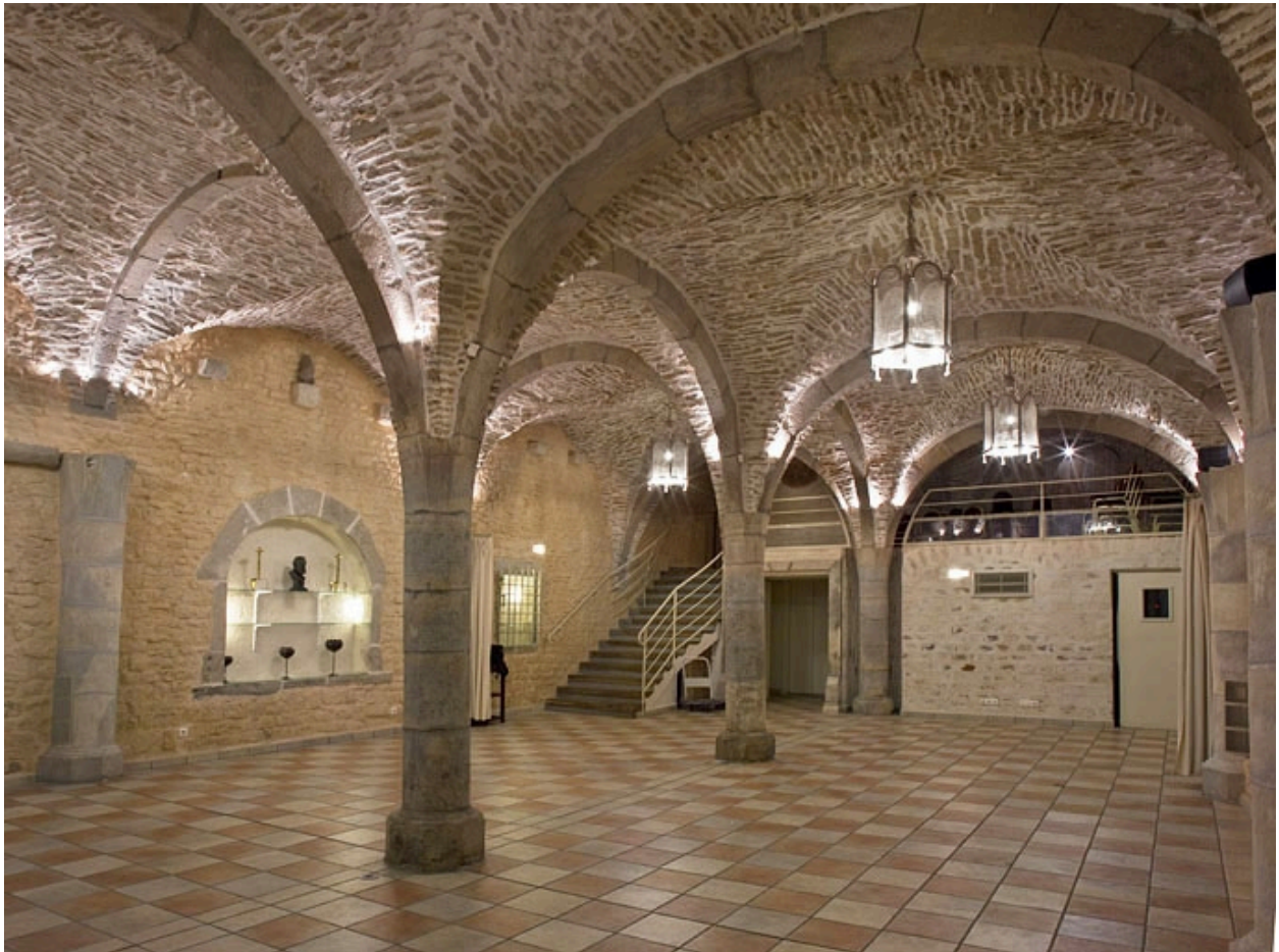
Vue d'ensemble de la cave depuis le fond, de trois quarts droit.
