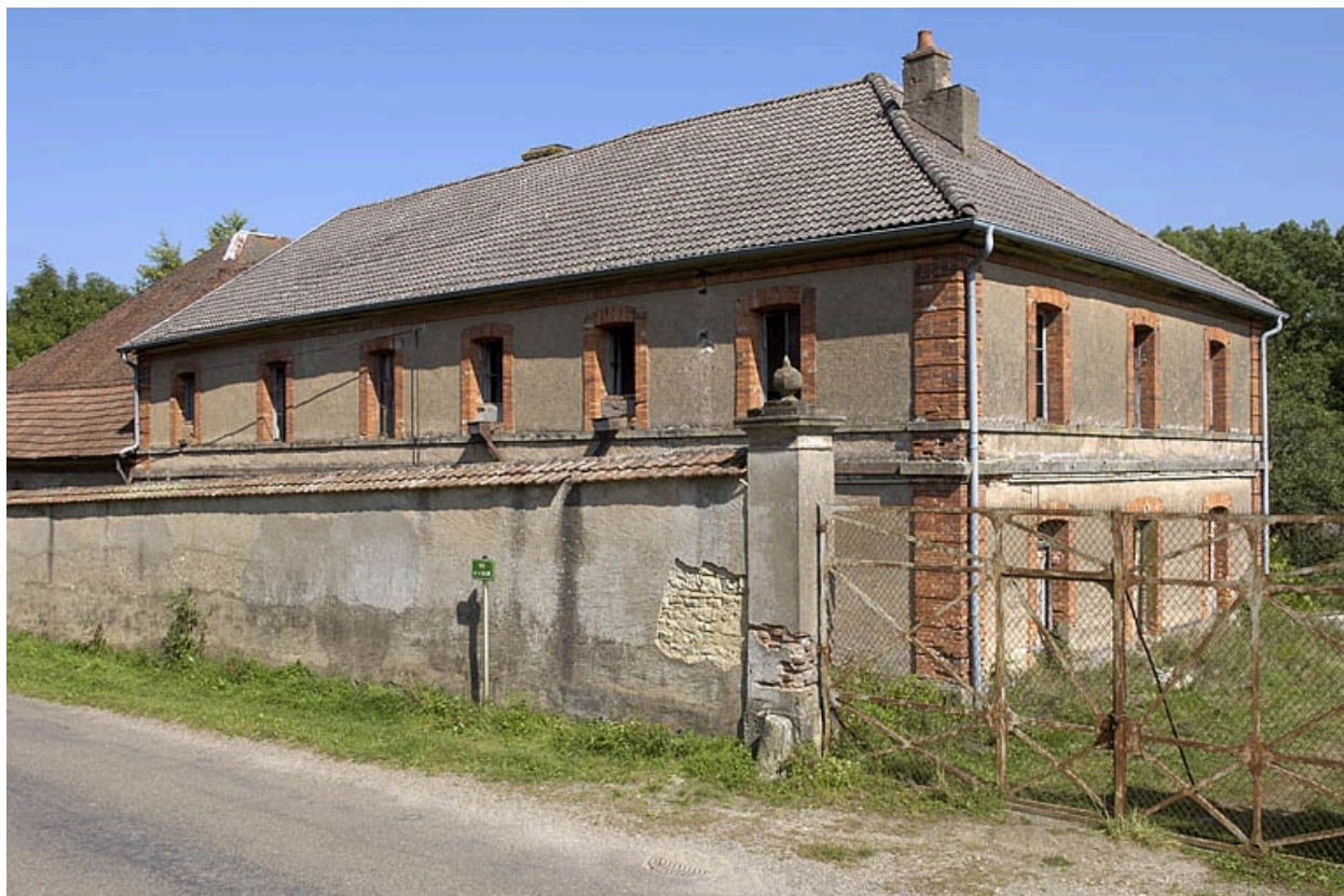
Saline de Mélecey : bâtiment du logement et des bureaux.
