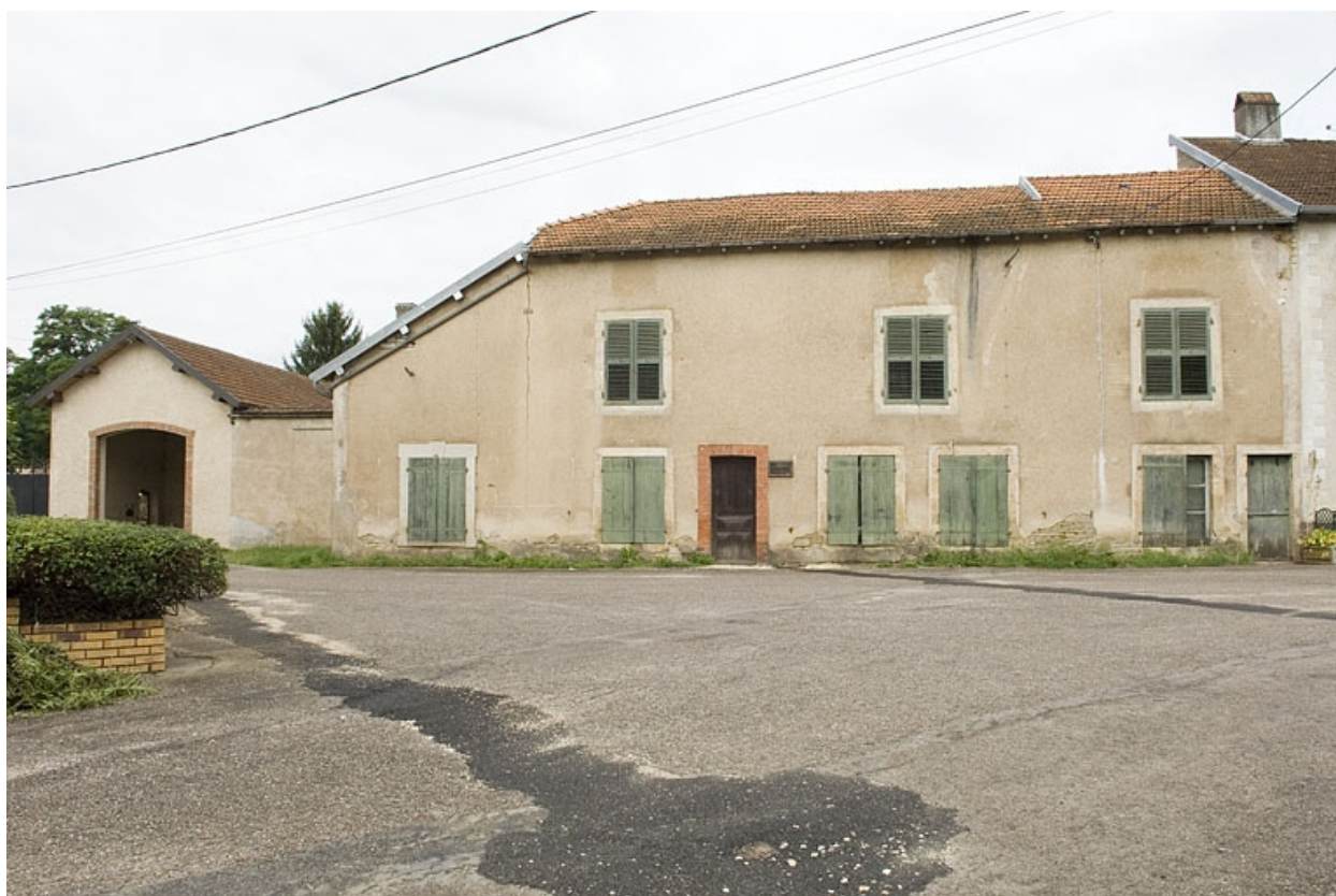
Vue du bâtiment d'entrée.
