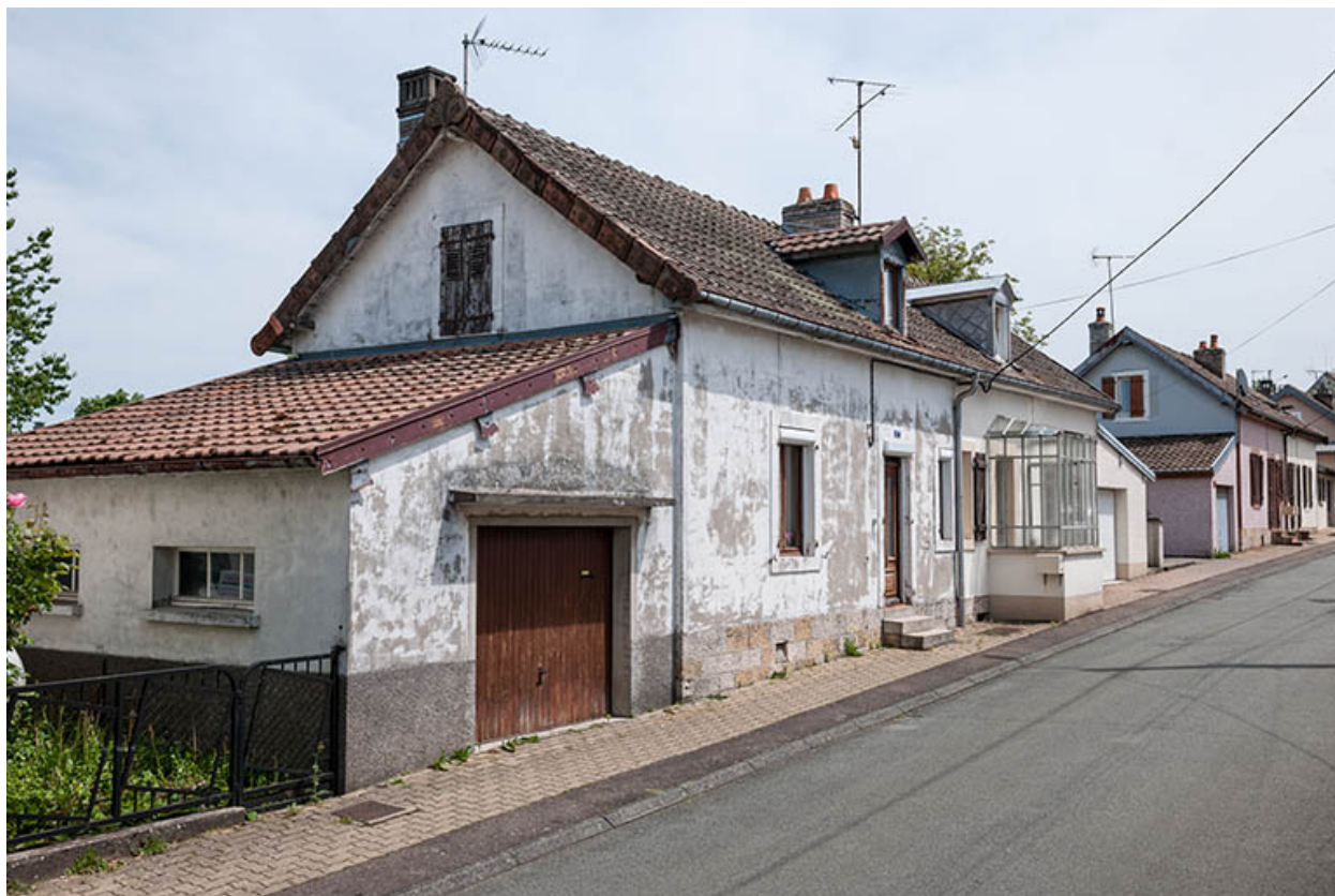
Maisons jumelées rue de la cité Meiner.
