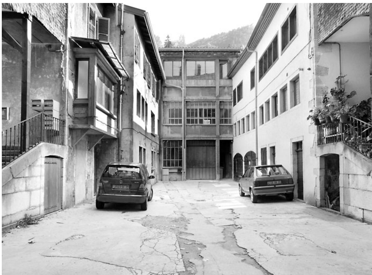
Vue d'ensemble des bâtiments dans la cour.
