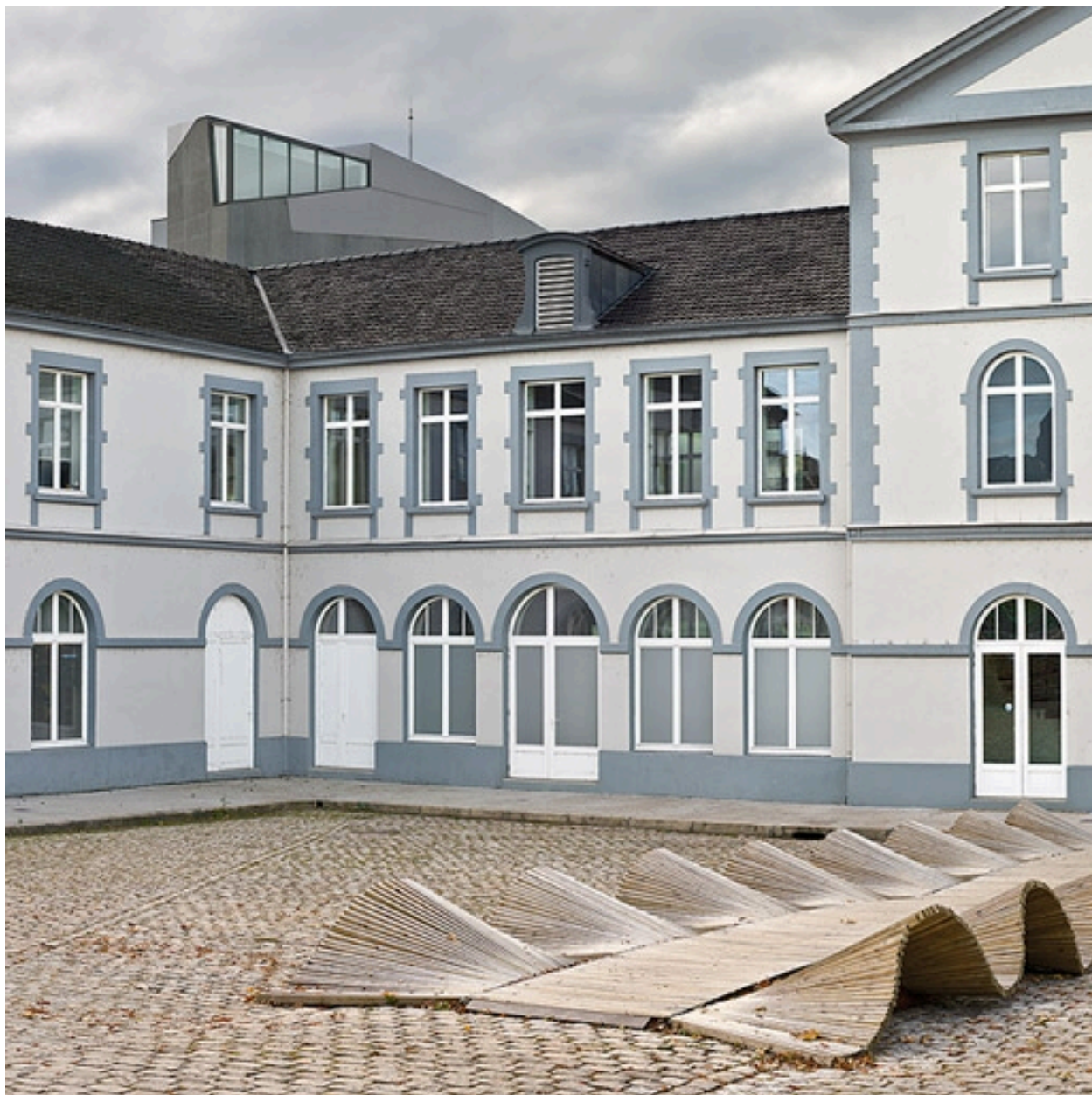
Vue extérieure : détail de la façade.
