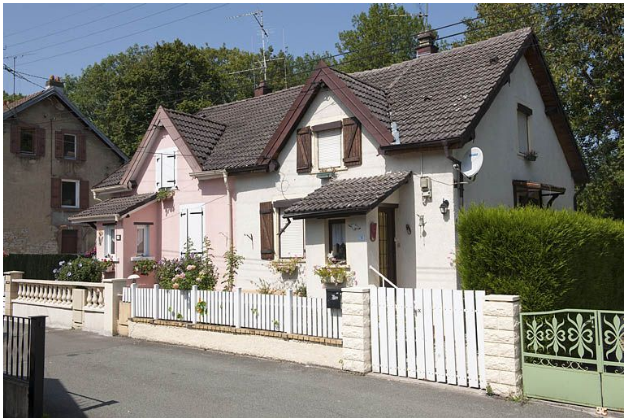
Maison jumelée rue des Campenottes.
