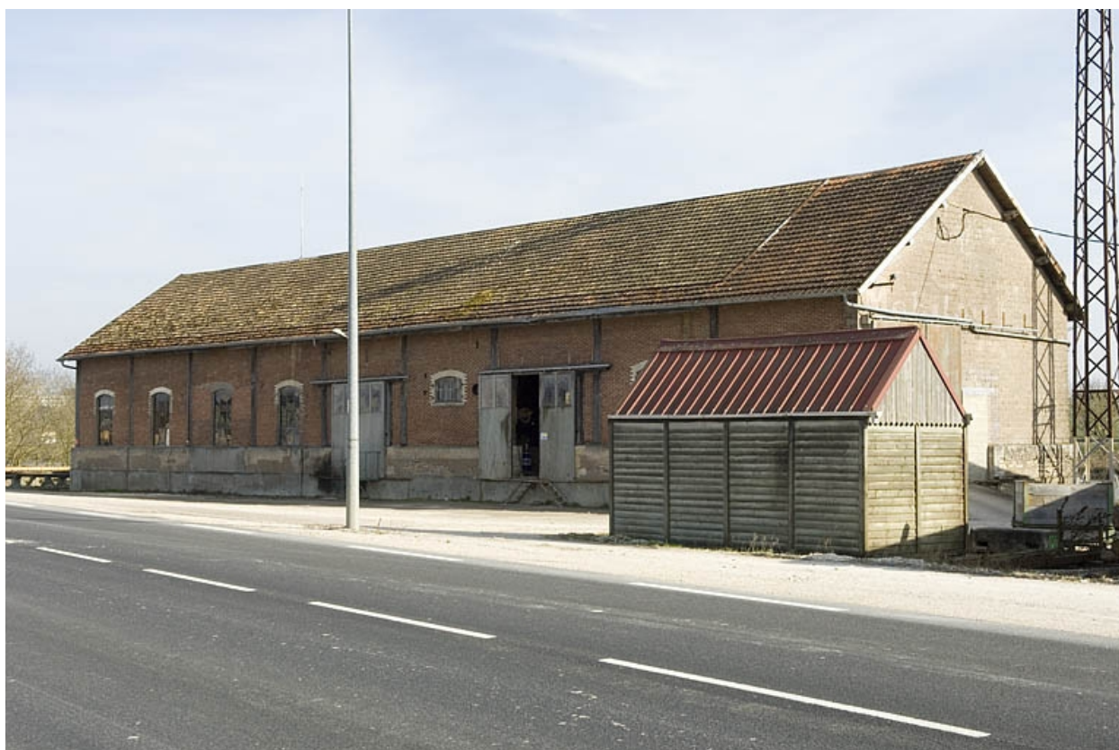
Magasin industriel depuis le nord-ouest.
