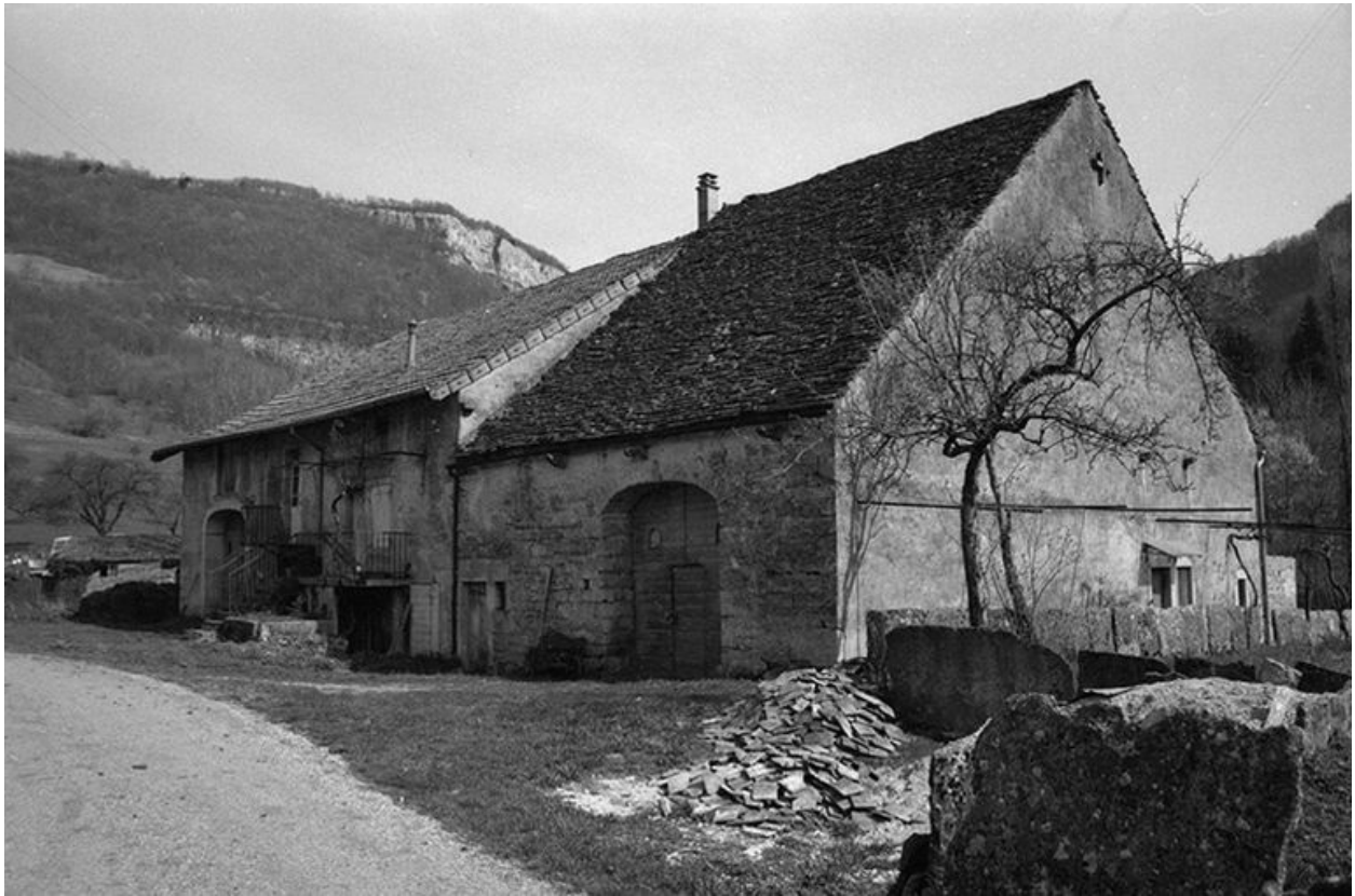
Ferme située rue du Chalet.
