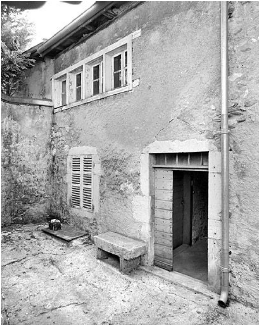
Façade postérieure du bâtiment oriental.
