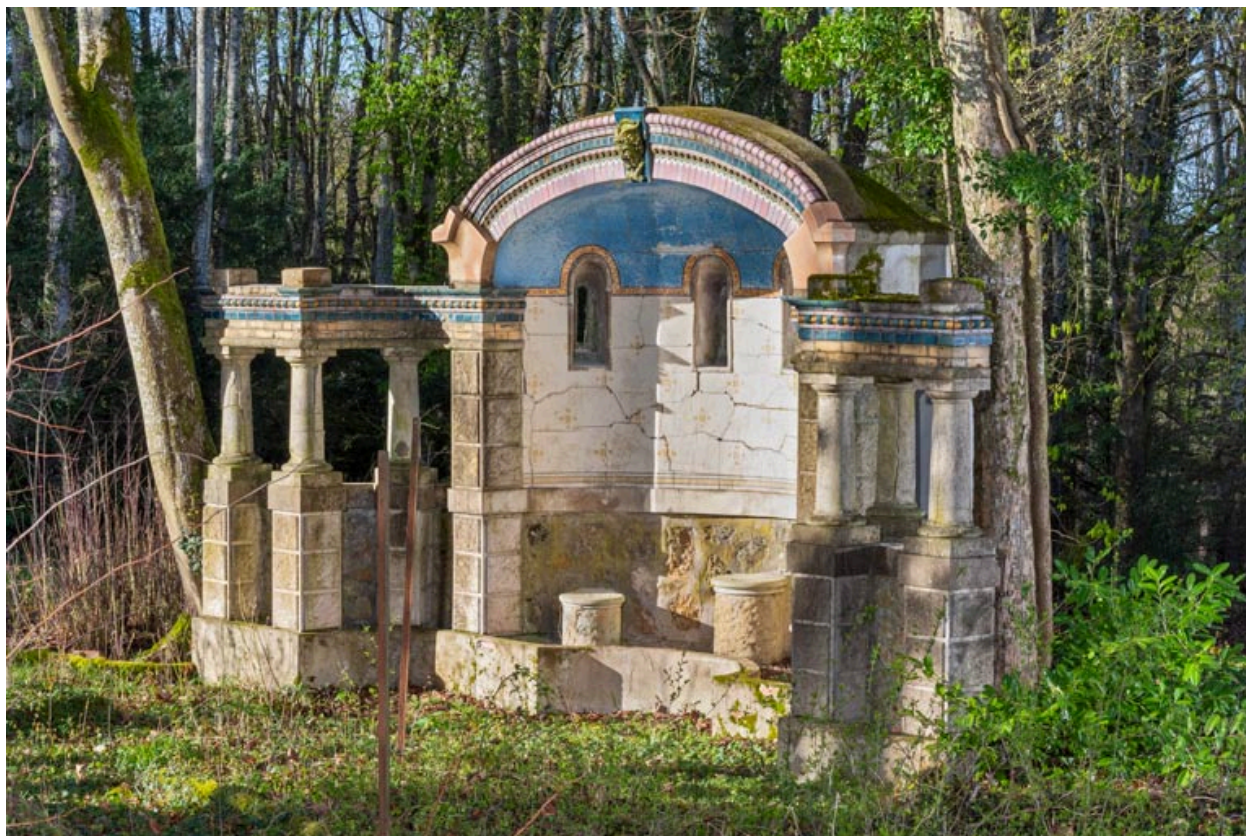
Face principale (vue de trois quarts).
