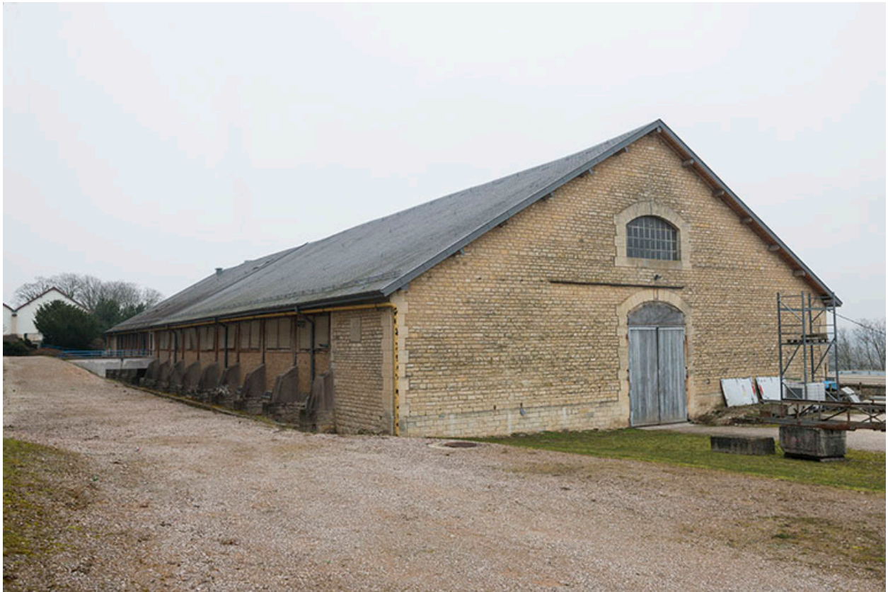
Pignon sud-est et façade sud-ouest de l'ancien manège-atelier.
