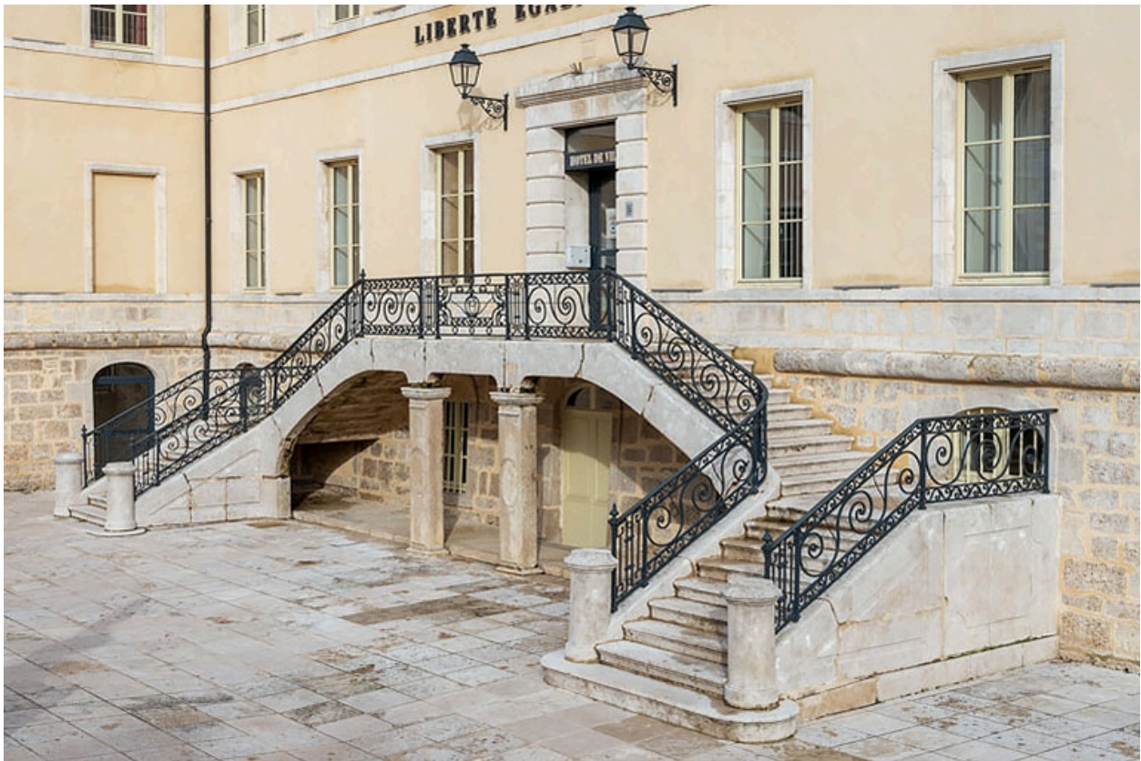
Aile est, façade antérieure : escalier.
