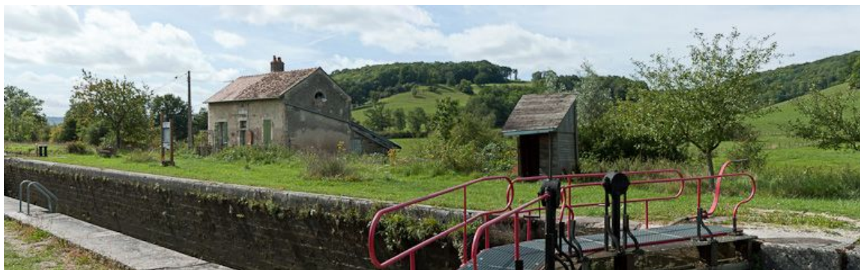
Vue d'ensemble du site d'écluse.
