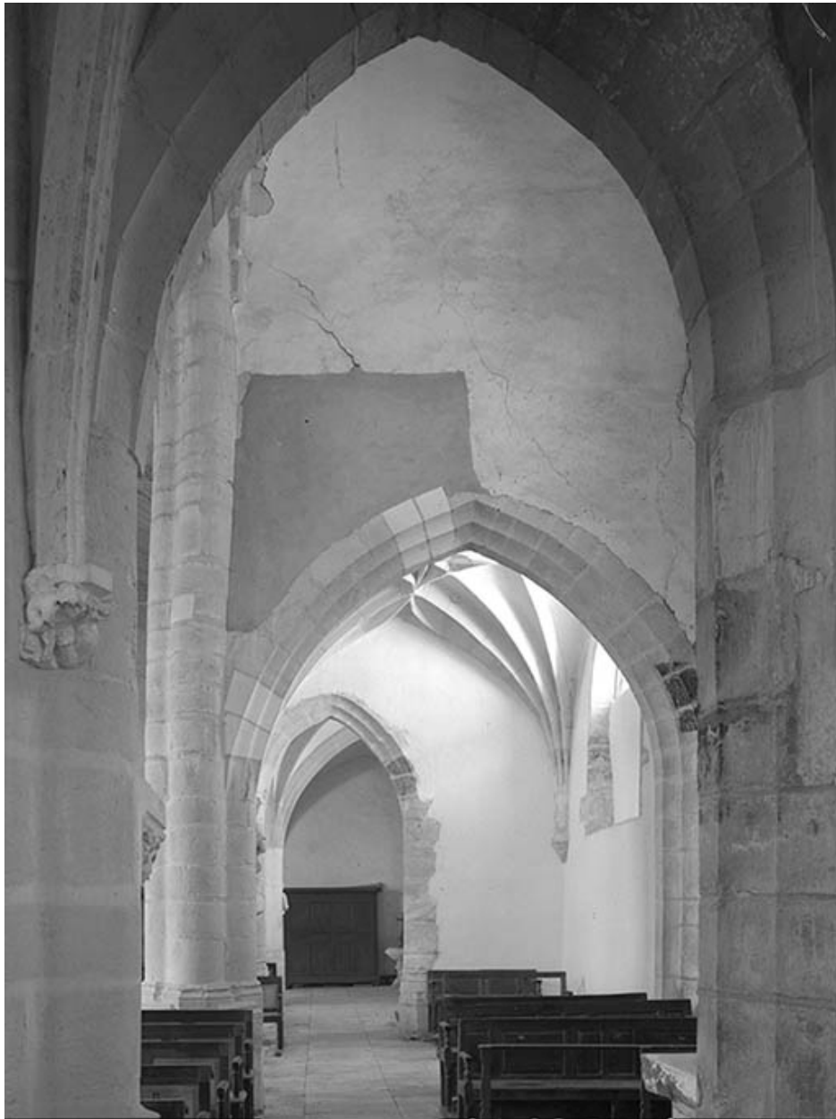
Collatéral gauche, vue depuis le mur postérieur.
