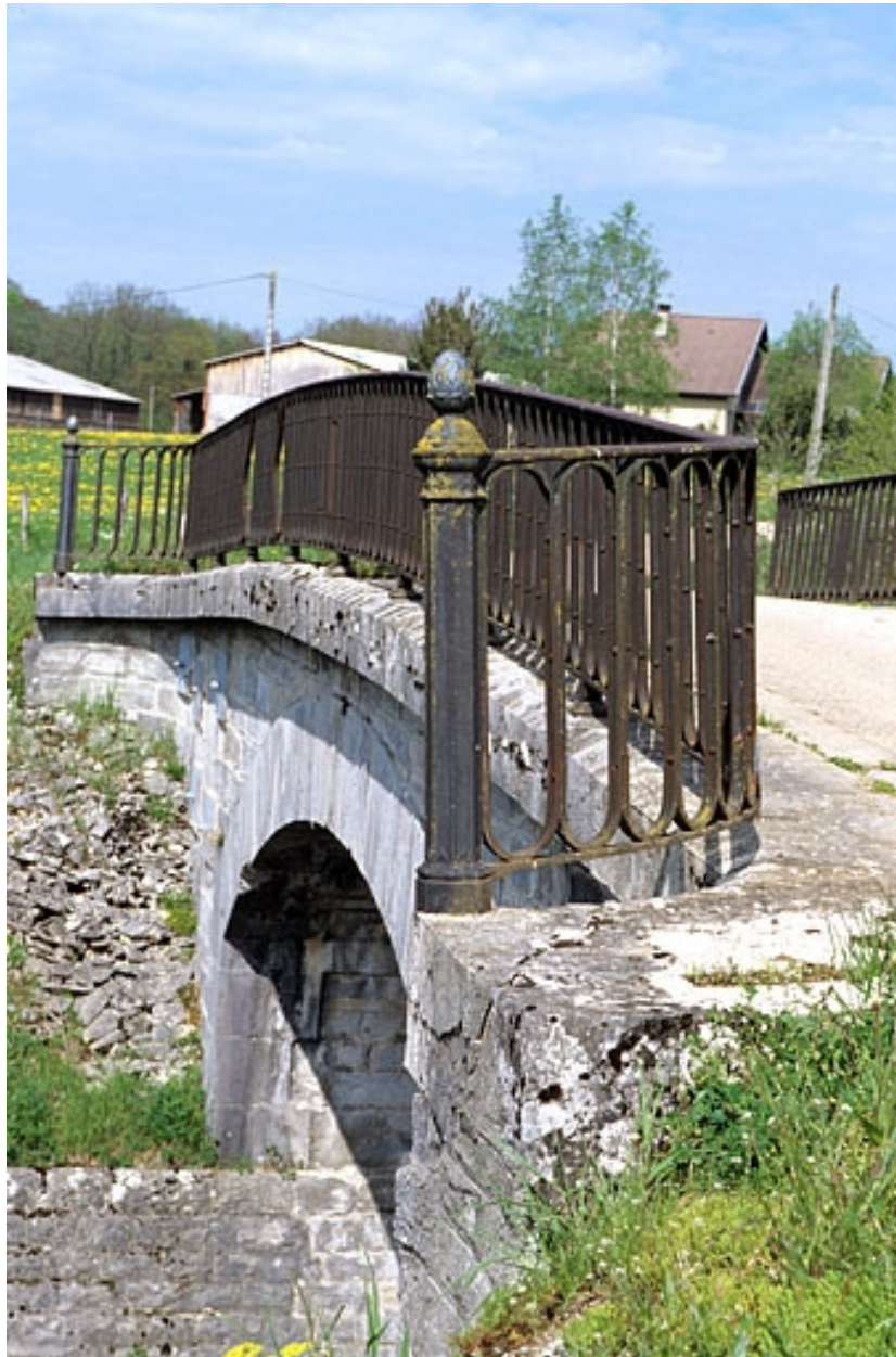
Vue d'ensemble du garde-corps nord.
