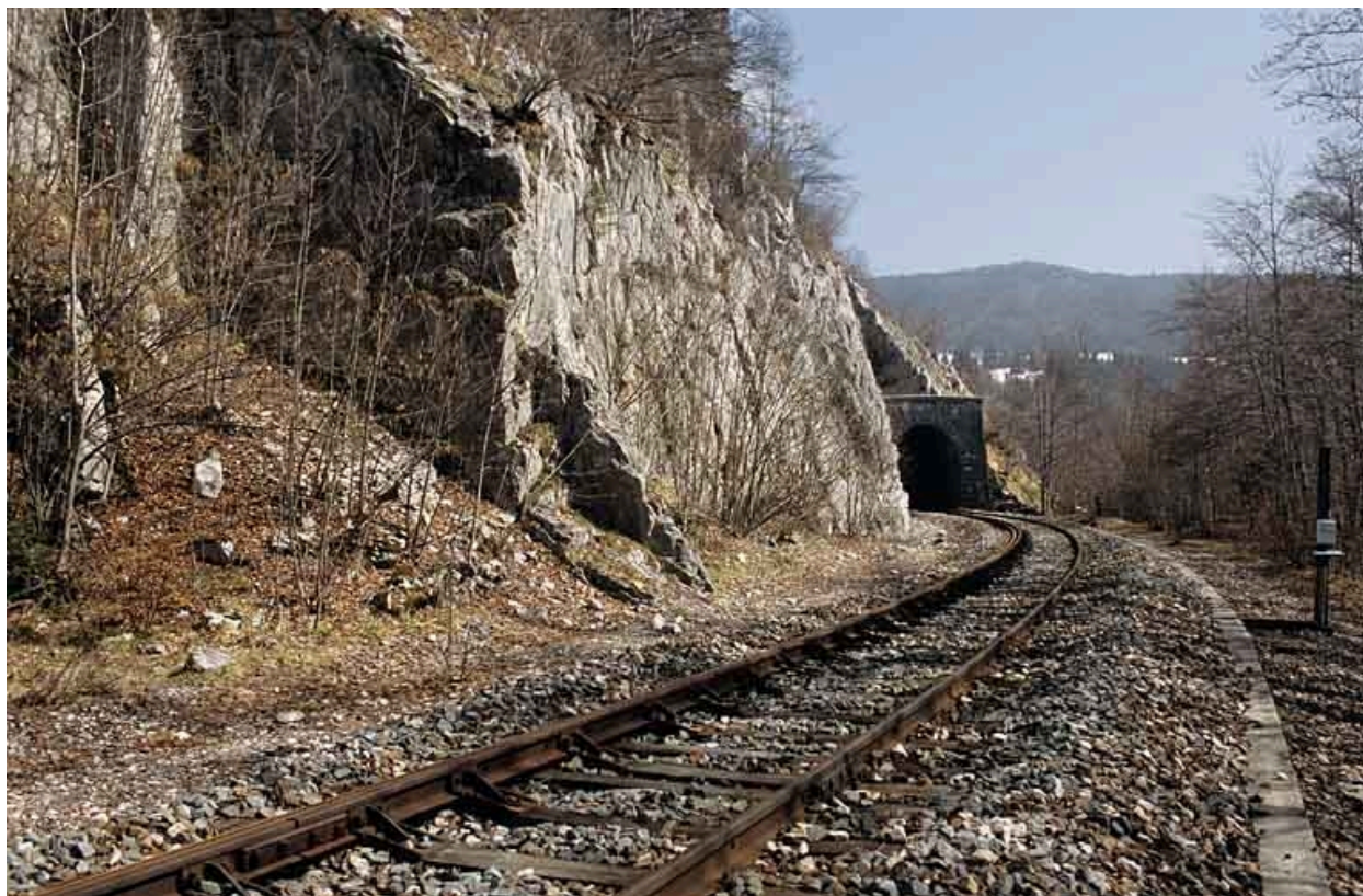
Vue d'ensemble, depuis le nord-ouest (côté Andelot-en-Montagne).
