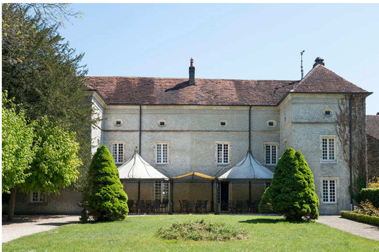
La façade postérieure.
