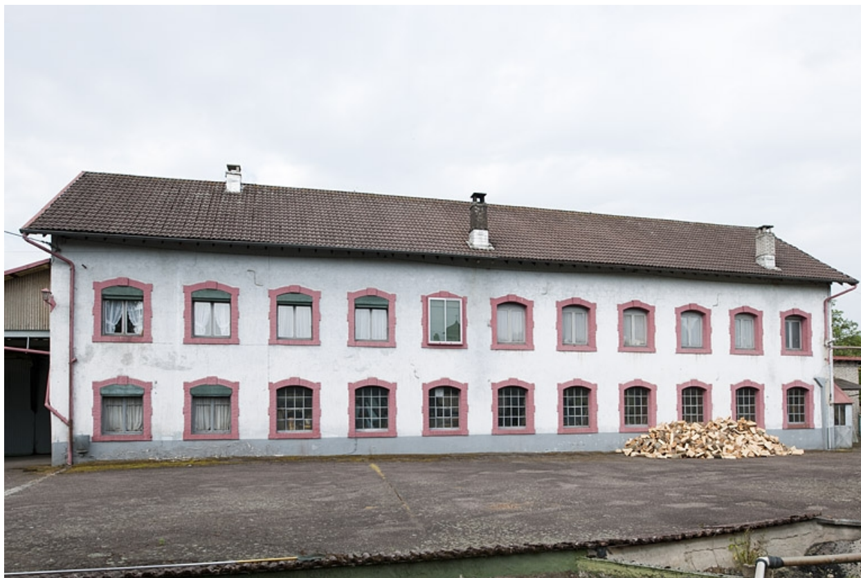
Atelier de fabrication. Façade antérieure.
