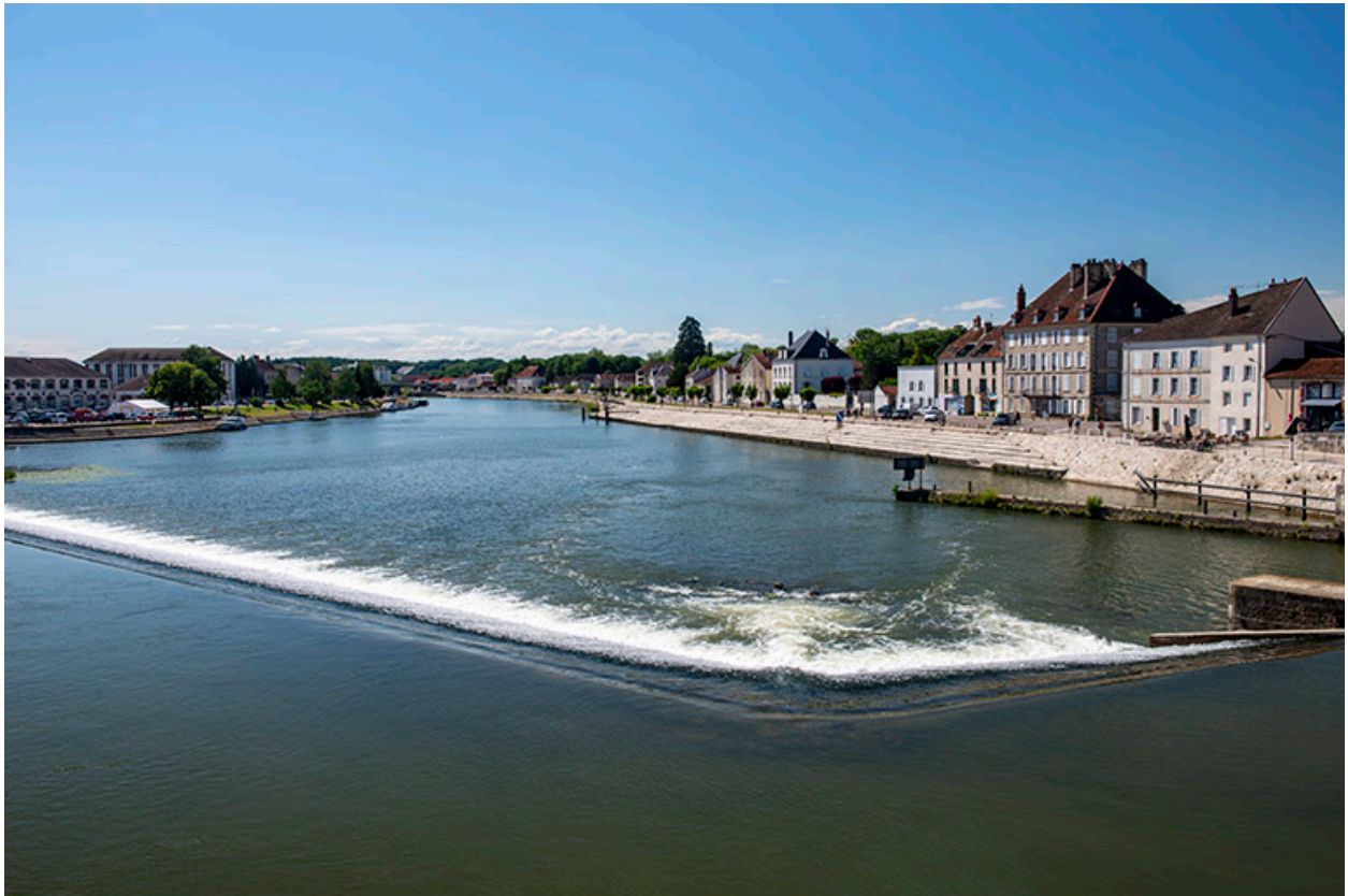
Vue d'ensemble des quais de la Mavia et Villeneuve depuis le pont en pierre.
