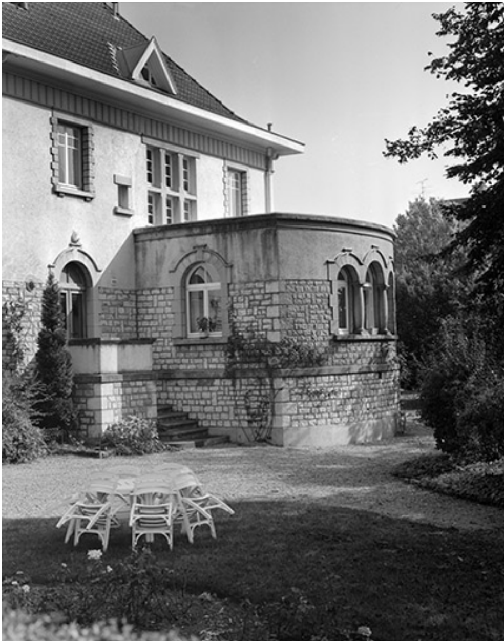
Détail de la face latérale droite de la maison 2, 4 avenue Alfred Solvay.
