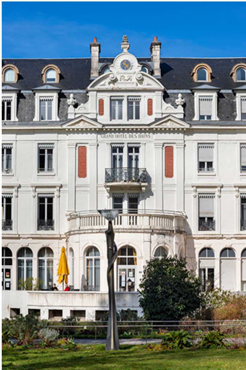
Façade sur le jardin, travées centrales.
