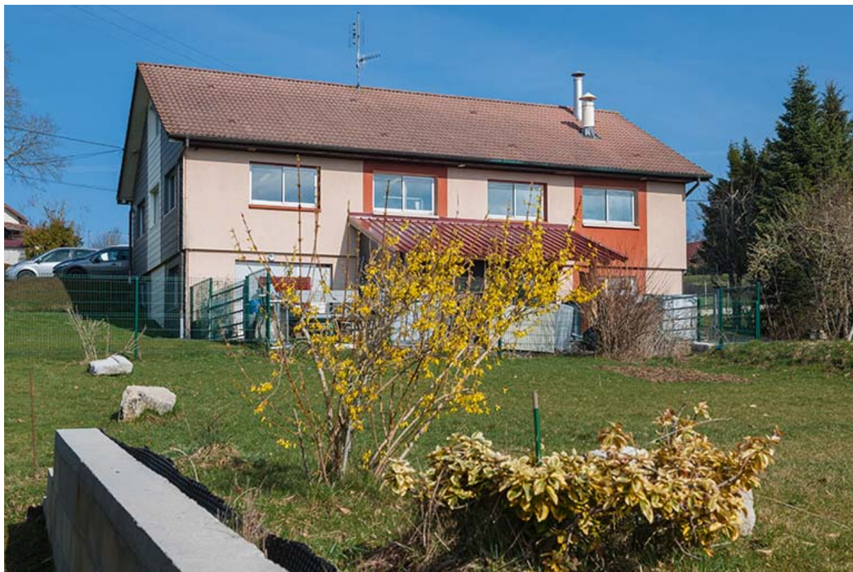
Usine : façade postérieure.
