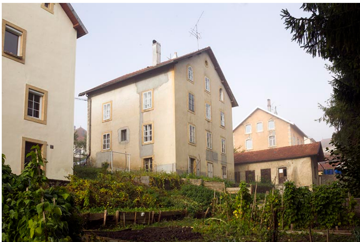
Façades postérieure et latérale droite.
