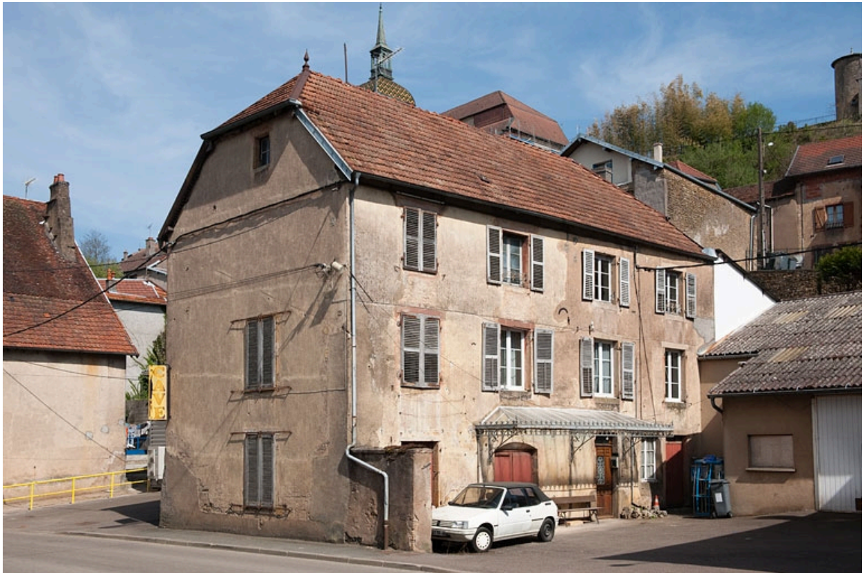
Vue générale du bâtiment (AL 543) situé à gauche de la cour.
