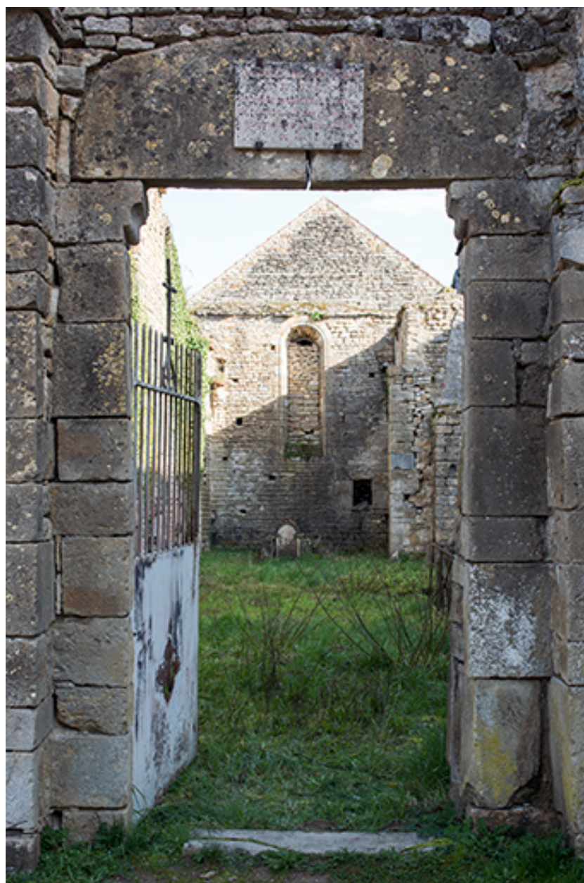
L'entrée de l'ancienne église depuis la rue.
