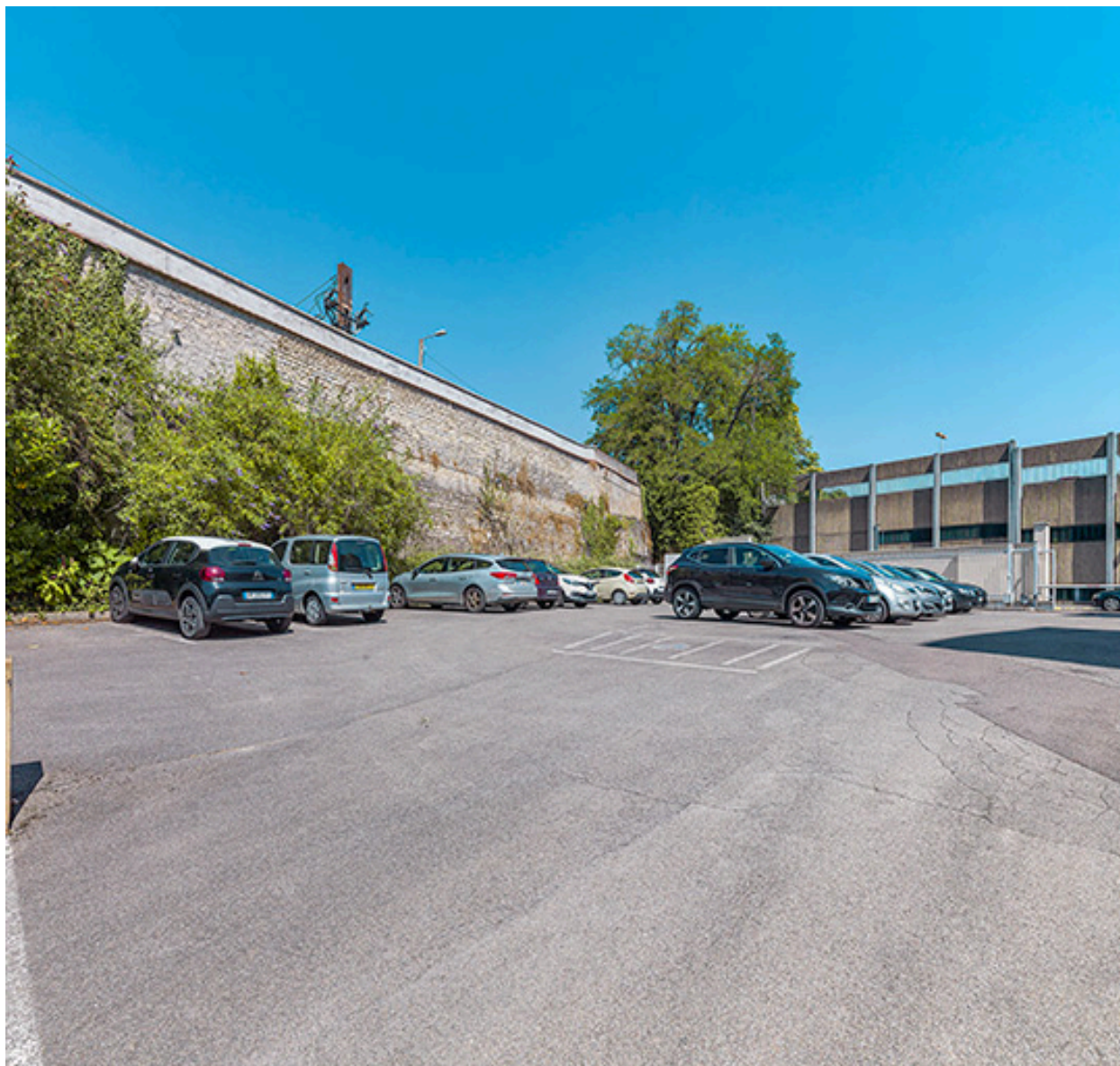
Elévation du rempart de la Miséricorde.
