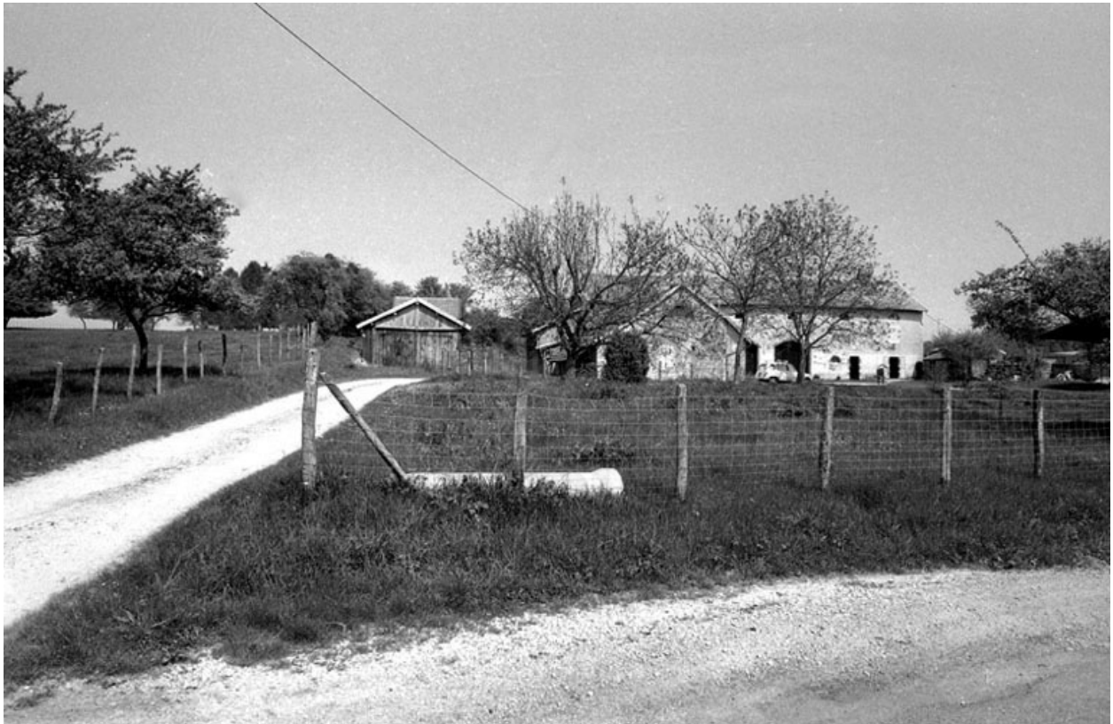
Ferme située au lieudit Les Vieilles Vignes : vue d'ensemble.
