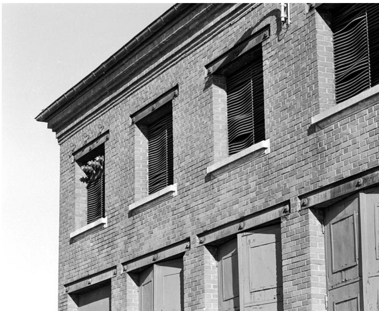
Transformateur : détail des baies supérieures de la façade ouest.
