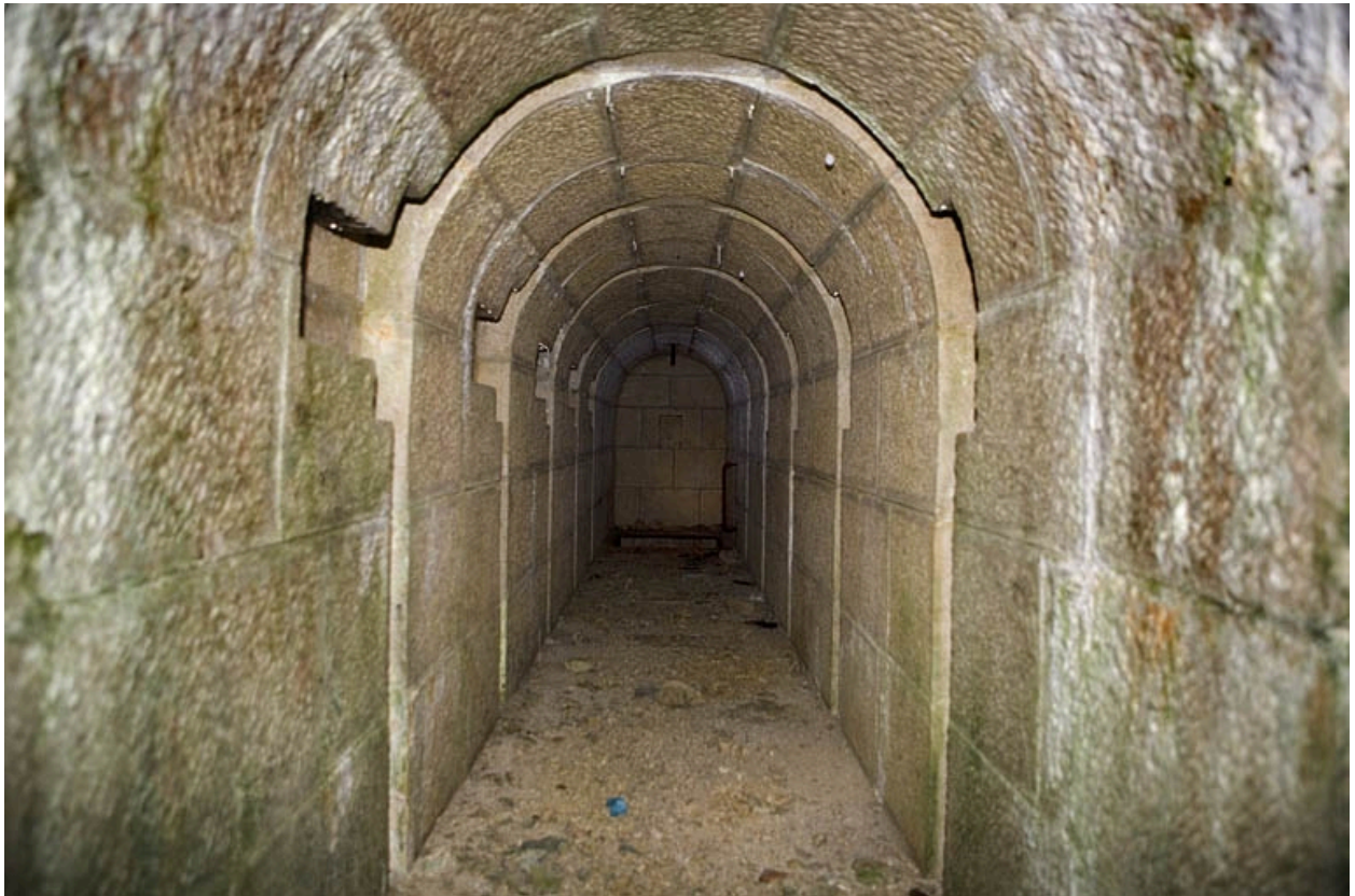
Chambres de mine sud-ouest : galerie, vue depuis l'entrée.
