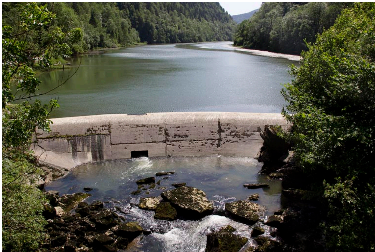
Barrage de la Goule : face aval.
