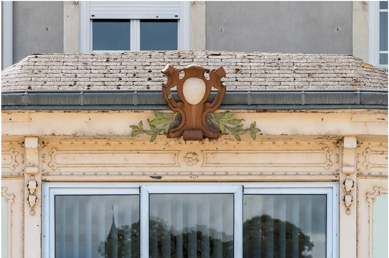
Aile ouest, salle à manger, détail.
