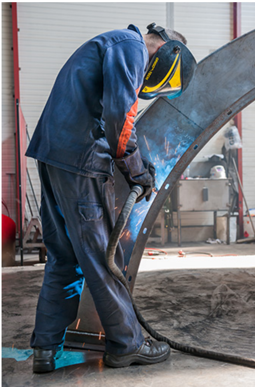
Opération de soudage.
