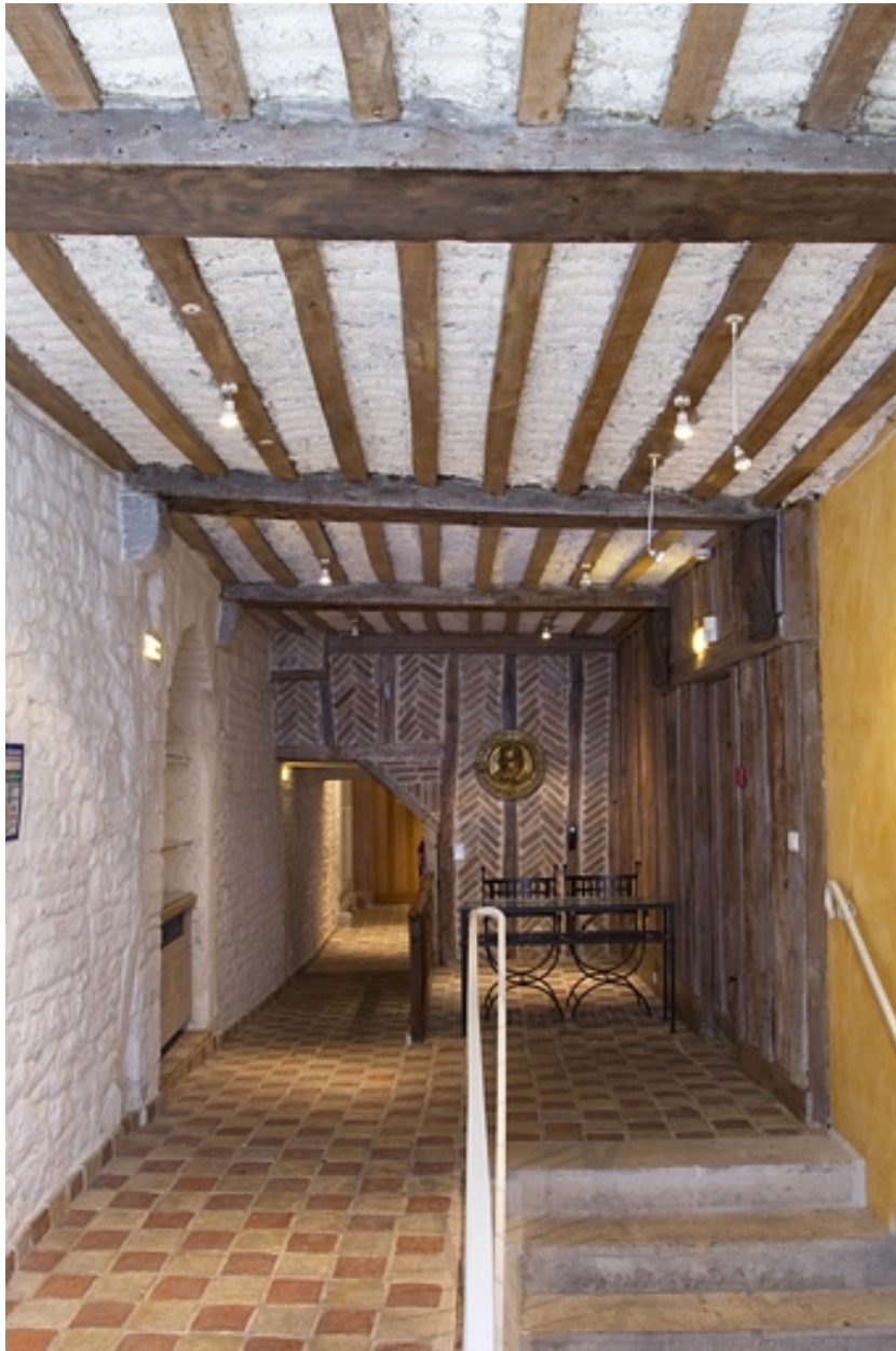
Vue d'ensemble du couloir.
