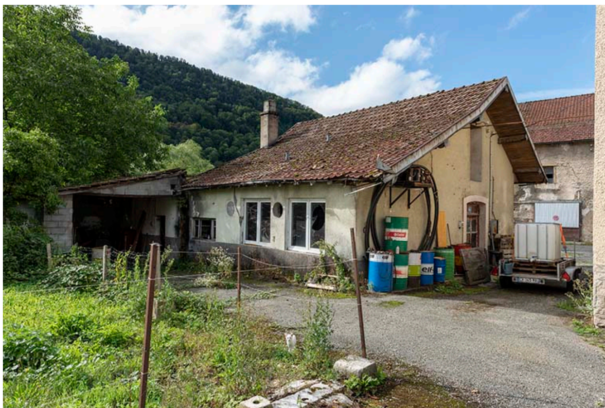
Façades antérieure et latérale gauche.
