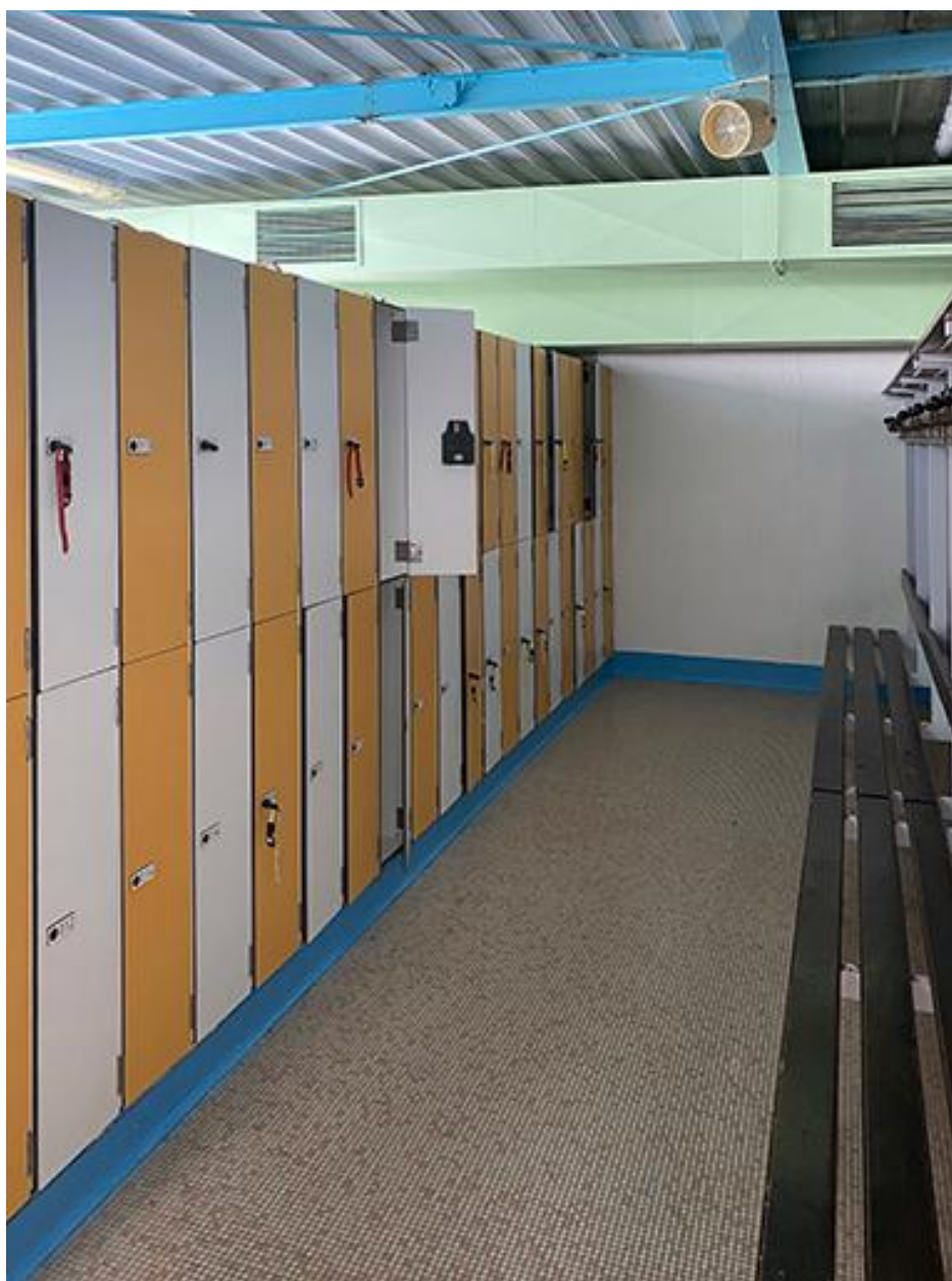
File des casiers et des bancs à patères.
