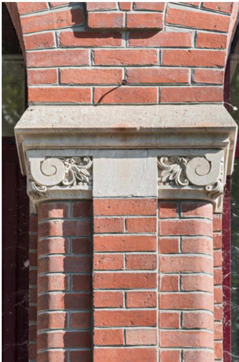
Détail du chapiteau d'inspiration ionique dans la galerie ouverte, de face.
