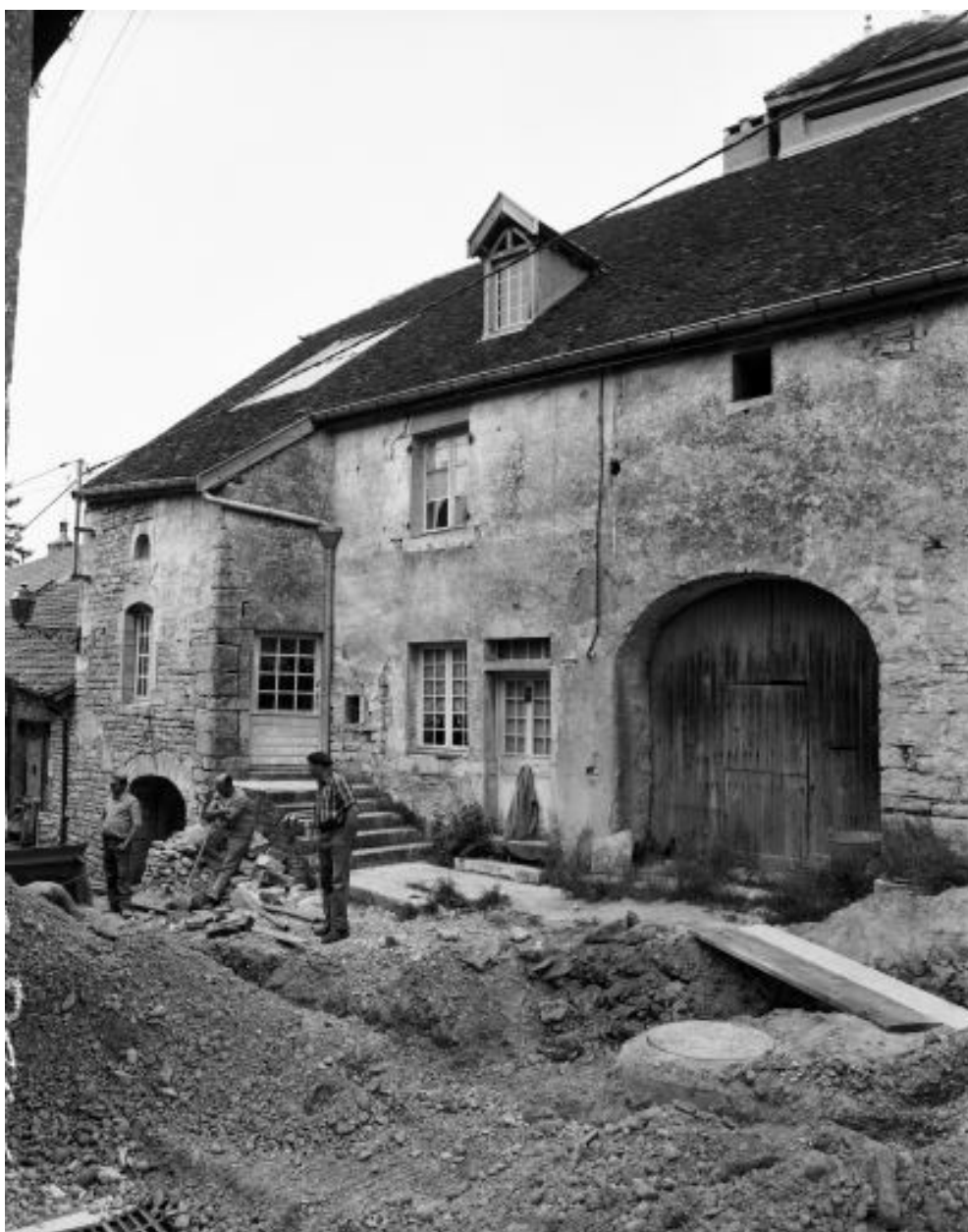
Façade antérieure, partie gauche.
